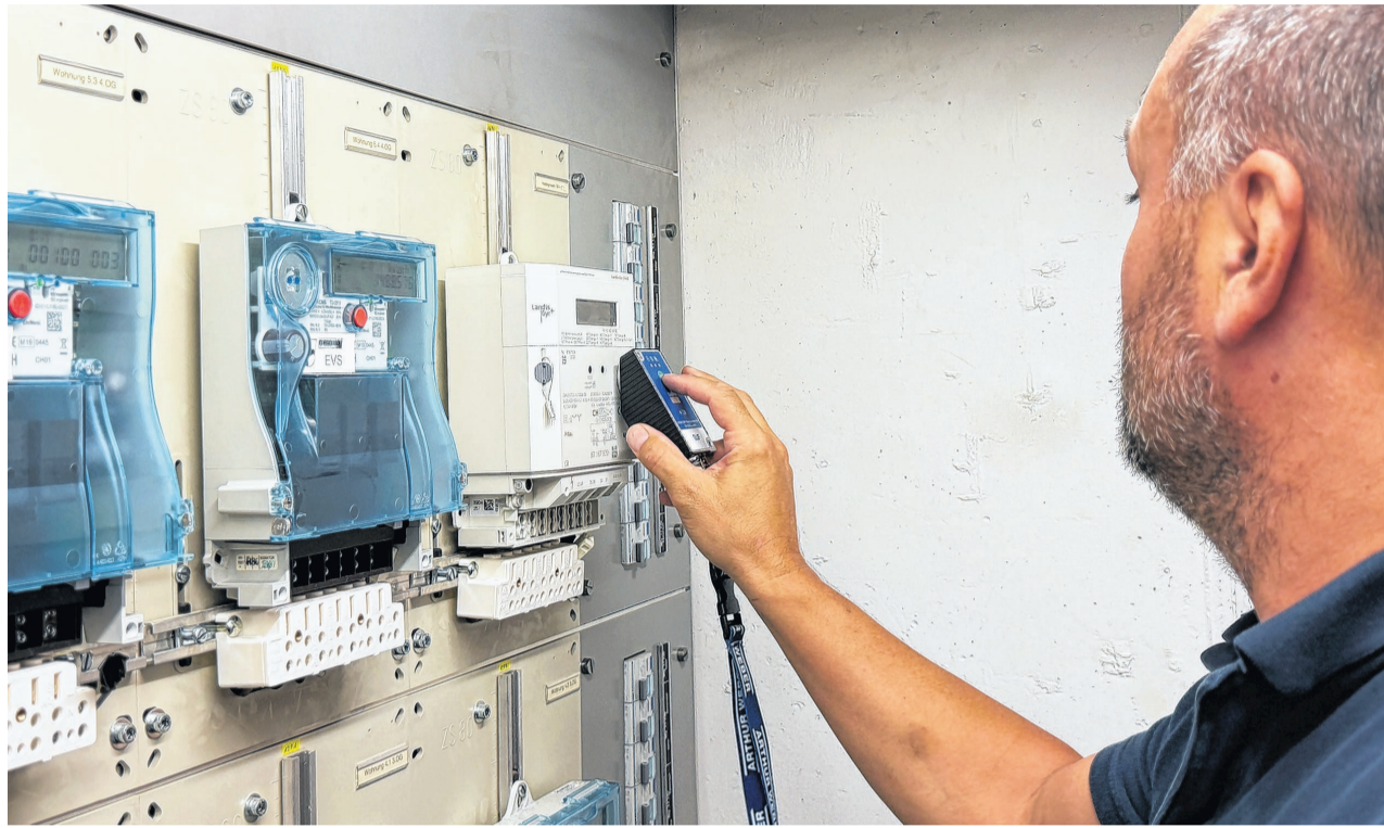
Ganz rechts ein Smartmeter der neusten Generation, links die etwa 15-jährigen Smartmeter, die alle ausgewechselt werden.
