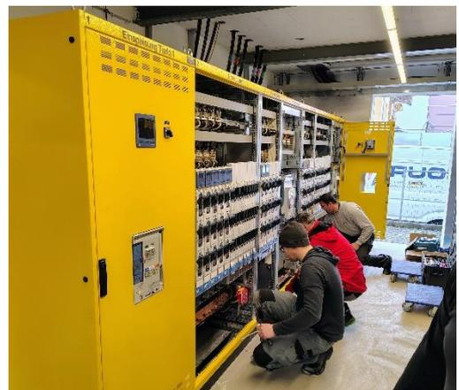
Bild 2 und 3: Anlieferung und Installation der neuen Trafostation.
